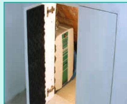
La dimensione compatta offre notevoli risparmi di spazio e può essere installata nascosta in piccoli mobili o anfratti, mantenendo comunque una performance elevate in termini di potenza aspirante ed una consistente capacità di raccolta polvere (fino ad 11 litri).
